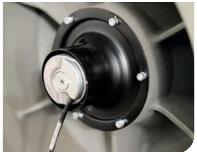
Imagen del Codificador instalado en el motor.
