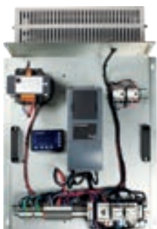
Inversor de potencia instalado dentro del pozo del ascensor.
